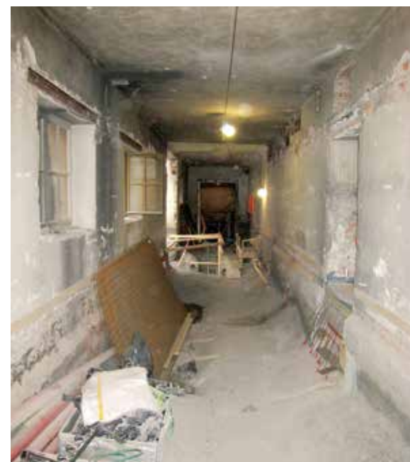
Korridor mot Nordahl Bruns gate, før og etter ombyggingen. Alle gulv på grunn måtte fjernes på grunn av alunskifer og radonsikres. Corridor along Nordahl Bruns gate before and after the refurbishment. Foto: Finn Ståle Feldberg
