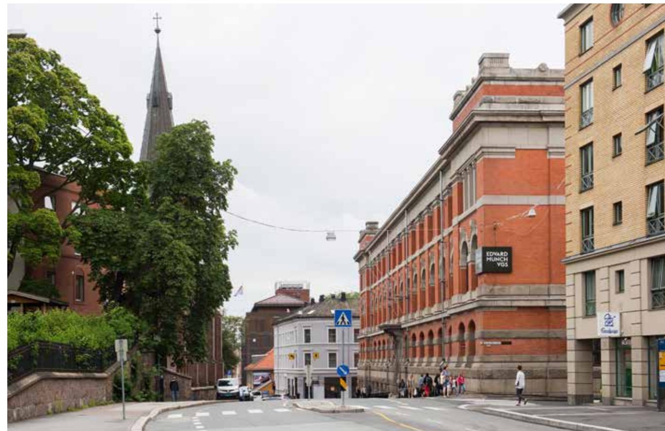
Et monumentalbygg i byen. Edvard Munch videregående skole sett fra Ullevålsveien. A monumental building in the city centre. Edvard Munch School seen from Ullevålsveien.
